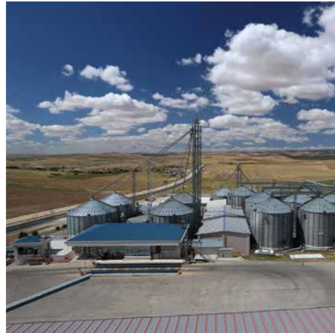
Tadim Produktionsstätte Kirikkale, Türkei / Tadim Kirikkale Production Facility
