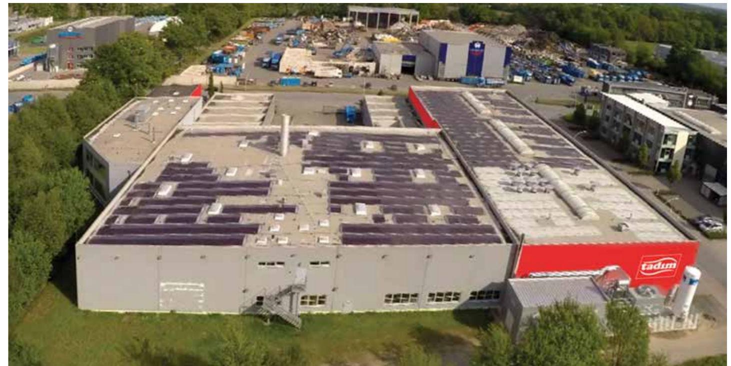
Tadı́m GmbH Produktionsstätte Emsdetten, Deutschland / Tadı́m GmbH Production Facility
