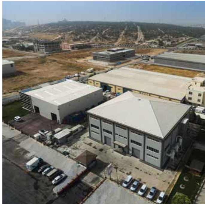
Tadim Produktionsstätte Gaziantep, Türkei / Tadim Gaziantep Production Facility
